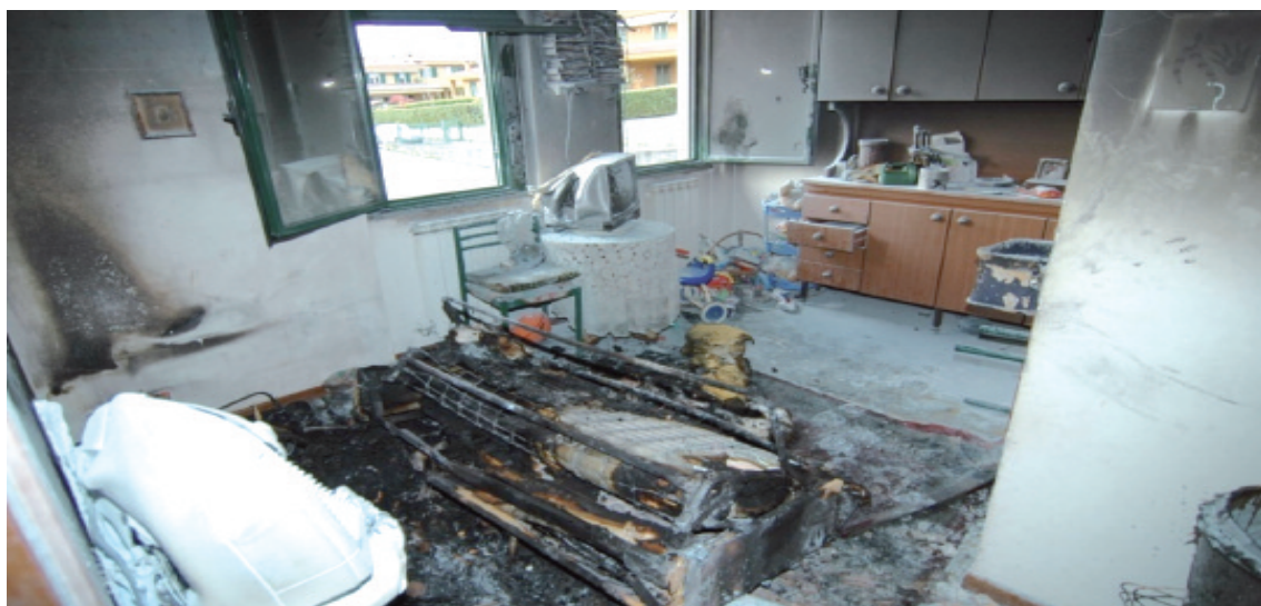
Scenario di incendio di abitazione: la cucina
